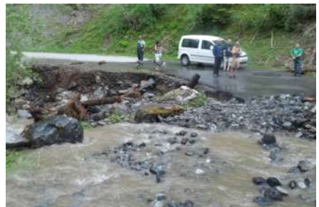
La route vers les granges de Lurgues, impactée par la crue du Lavedan.
