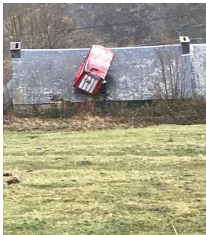
Une bétailière rouge sur le toit d'une grange à Aspin-Aure après les intempéries de décembre 2019
