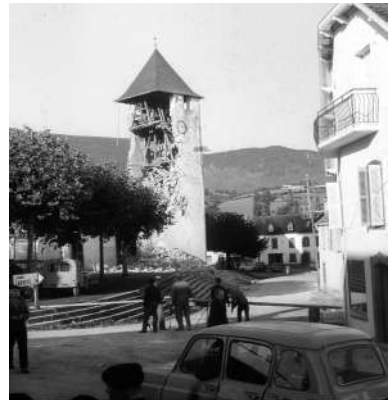
Le clocher de l'église d'Arette (64) après le séisme de 1967 (archives de la Mairie d'Arette)
