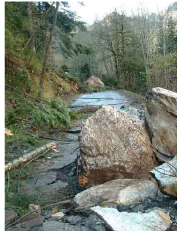
Éboulement du 19 novembre 2008 sur la RD30. (Photo : JB DUBARRY)
