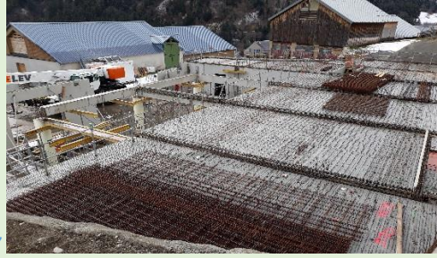
Photo de la dalle R+1 en décembre 2017
